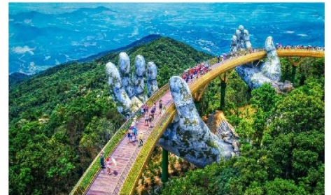
สะพานลอยฟ้า Golden Bridge
